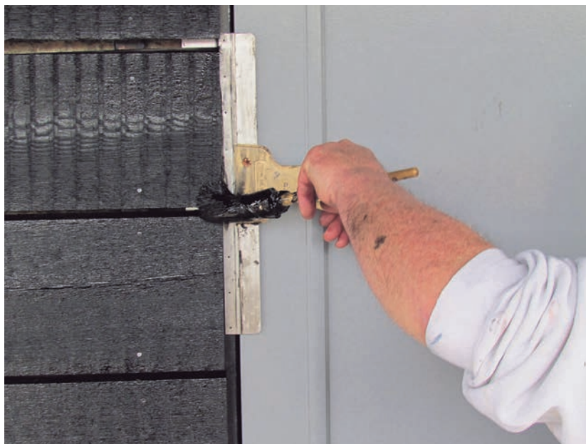
De truc met het spachtelmes om de kopse kanten goed in te kunnen soppen
