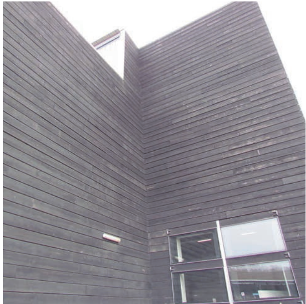
De oude situatie, na ruim 12 jaar: lichte verkleuring, hier en daar wel erg schrale plekken, verder niets aan de hand
