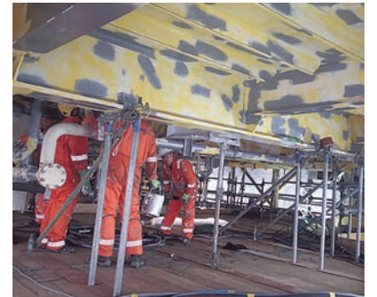
De gecorrodeerde delen zijn gestraald en worden aangeplekt
