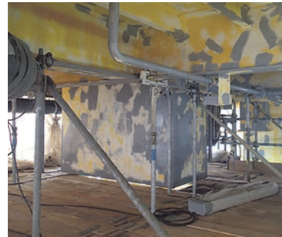
De steigerbouwers bouwden een hangende steiger onder het platform
