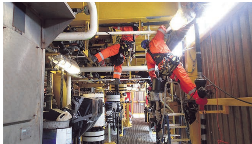
Het boren naar aardgas op productieplatform draait gewoon door tijdens de onderhoudswerkzaamheden van Venko Offshore
