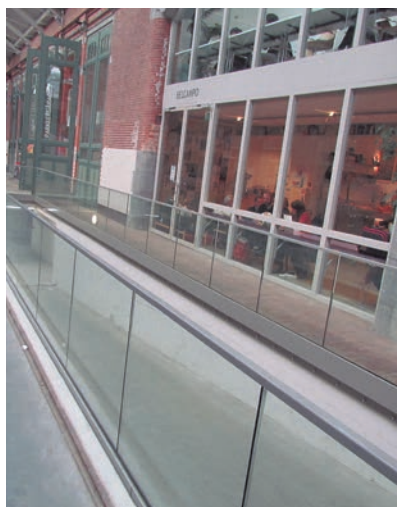
Al het glas in het complex werd door De Boer geplaatst, ook dit soort valveilig balustradeglas
