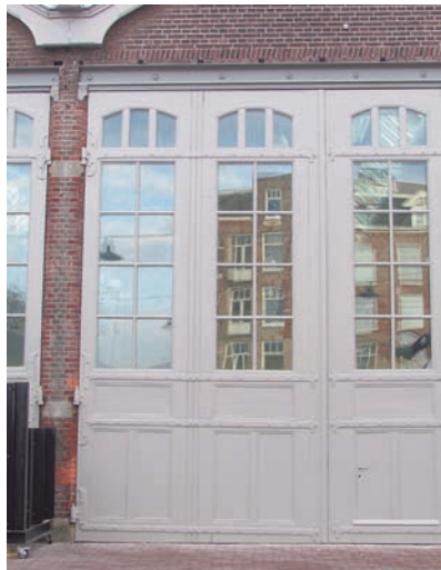
Door deze deuren reden de trams in en uit. In de werkplaats zijn ze gerestaureerd en beglaasd
