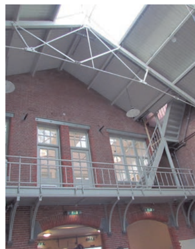
Duidelijk is te zien hoe architect André van Stigt de industriële herkomst van het gebouw benadrukt
