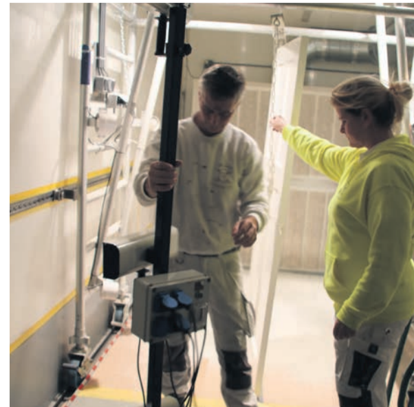
Voorzichtig wordt het QDS-droogstelsel in de vrachtwagen om het werkstuk geplaatst
