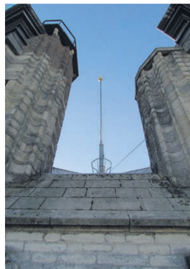
Voordat de stalen mast voor onderhoud aan de beurt is, moet die eerst gekanteld worden
