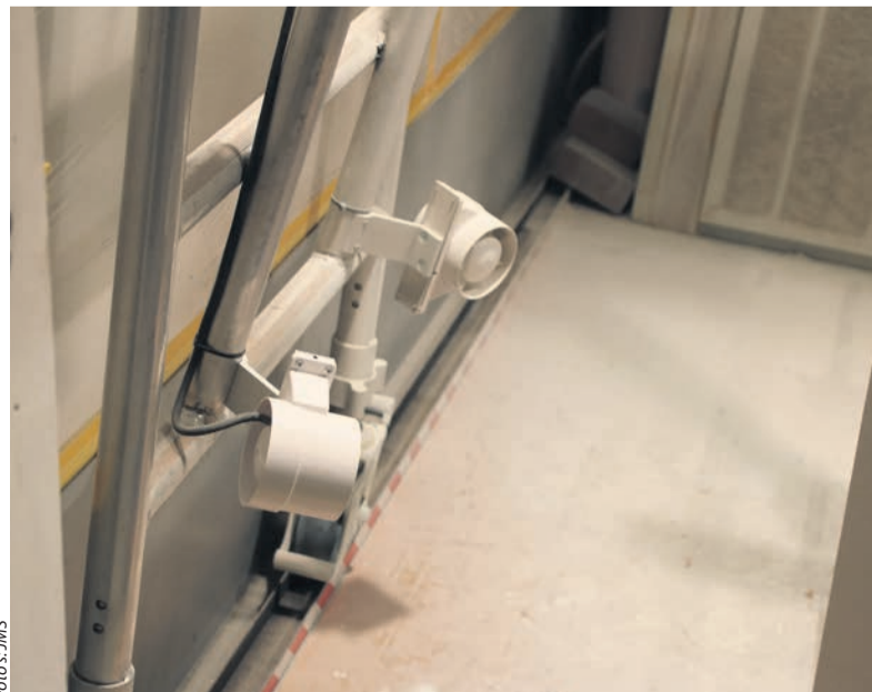
Een kleine innovatie: ventilatoren versnellen het droogproces
