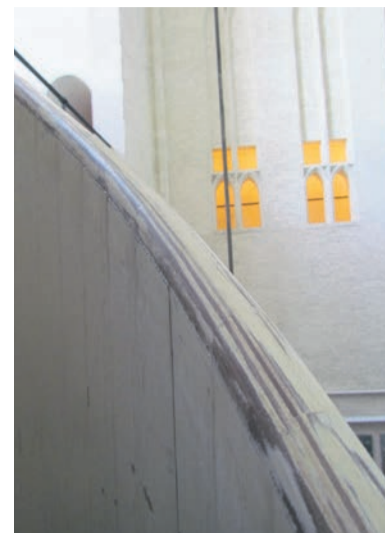
De vele bezoekers laten hun sporen na: kaal hout en een hoge mate van huidvetbelasting
