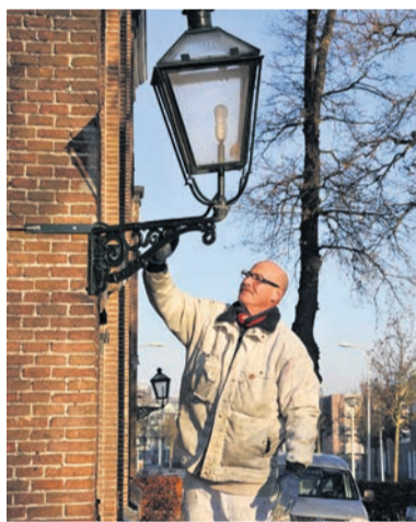
Roelof Kleine schuurt een ouderwetse karakteristieke stalen lantaarn
