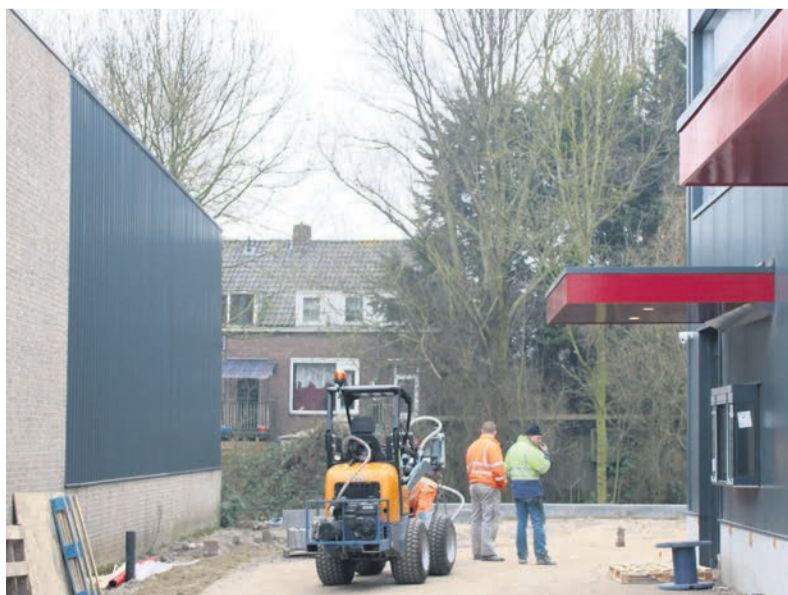
De metalen wand van het buurpand is ook geschilderd, de klanten van de drive-in komen namelijk achterlangs
