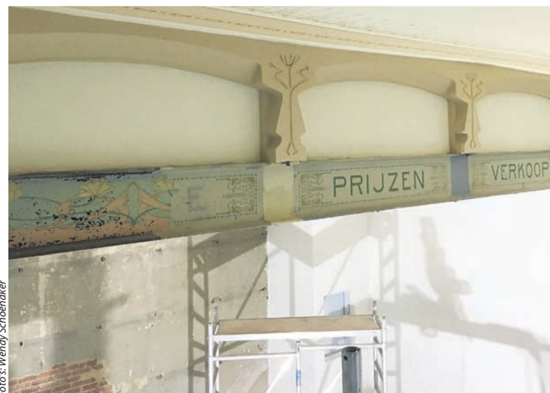
Het plafond en de ornamenten zijn al klaar. Nu de restauratie van de decoraties op de stalen draagbalk nog
