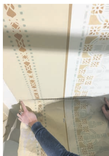
Dit is de bedoeling: een natuurgetrouwe reconstructie van het linnen behang
