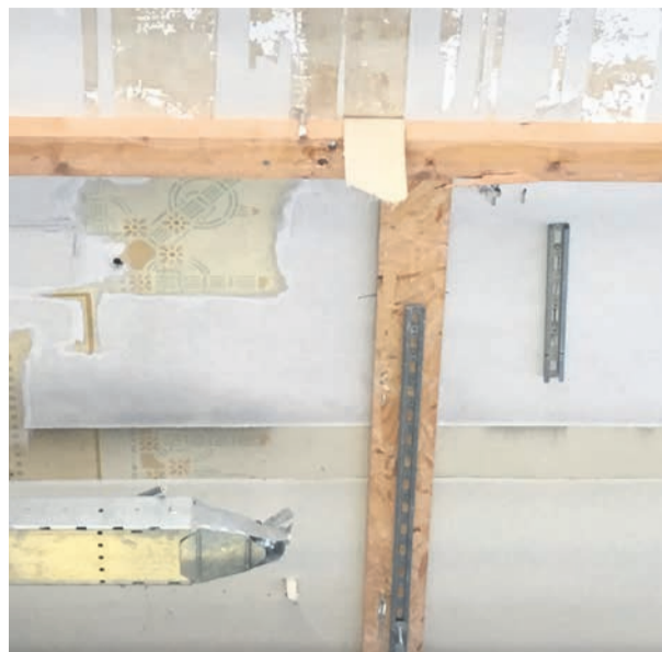
Dit soort beschadigingen kwam tevoorschijn. Het oude beschil- derende linnen is al zichtbaar
