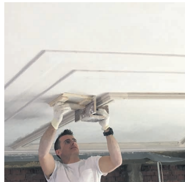
Restauratief stucwerk is een onderdeel van de totale reconstructie van het plafond
