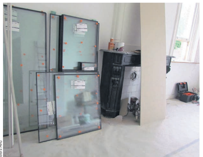
Met zijn onregelmatige spiegeling zorgt het historische dubbele isolatieglas van Stolker Glas ervoor dat het pand zijn oude gevelaanzicht behoudt
