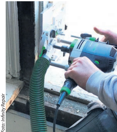
Het uitzfrezan van het slechte deel van het kozijn voert de onderhoudsmedewerker uit met behulp van de speciaal ontwikkelde freesmal
