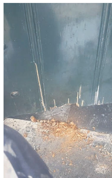
Houtrot in een van de deuren vroeg om bijzondere aandacht FOTO: RENÉ LEK
