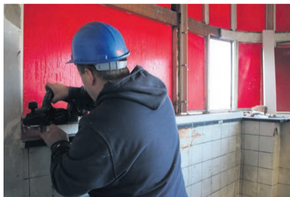
De ruiten met ondoorzichtig rood glas worden vervangen voor getrokken en gelaagd monumentenglas. Er kwam veel houtrot tevoorschijn, de kozijnen moeten eerst hersteld
