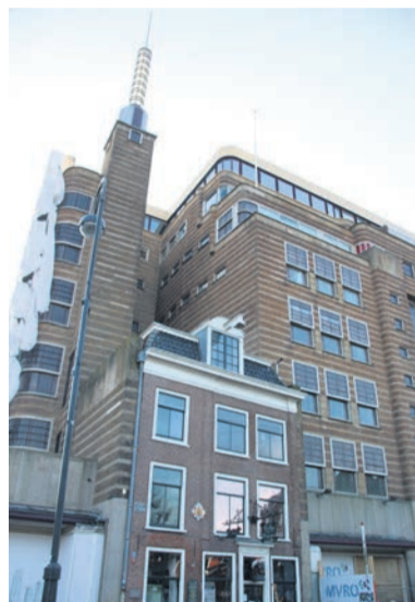
De gevels door Verhoeven Vastgoedverbeteraars helemaal in de steigers gezet, met 90 procent windreductie-gaas en kappen met krimpfolie. Bij één geveldeel niet, vanwege drogisterij Van der Pigge
