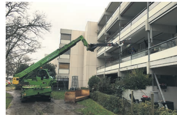
Veiligheid voorop bij het verwerken van asbesthoudende kitresten: afzetting, beschermende kleding, halfgelaatsmasker, afzuiging en een plastic ondergrond
