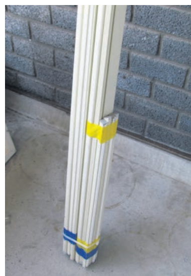
De glaslatten zijn op maat gemaakt, de kopsen kanten afgerond, voorbehandeld en gebundeld per woning en per kozijn aangeleverd FOTO: HVG
