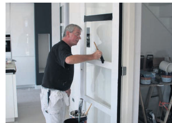
Bas Burema zet de watergedragen lakverf eerst met de kwast op en rolt het daarna met een viltrollertje uit. 'We zijn hier niet zo van de kaststrepen die je moet zien staan'
